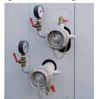
Kaltwasseranschluss mit Storz-Kupplungen
