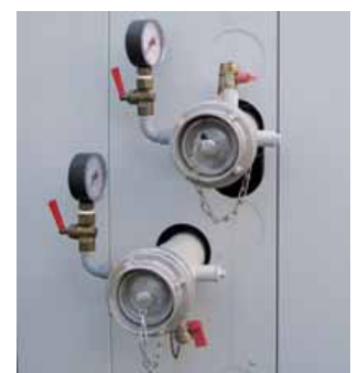
Kaltwasseranschluss mit Storz-Kupplungen
