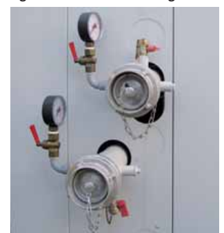
Kaltwasseranschluss mit Storz-Kupplungen
