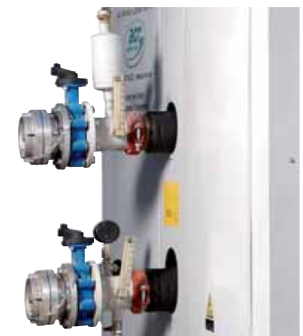
Kaltwasseranschluss mit Storz-Kupplungen
