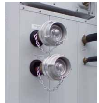
Kaltwasseranschluss mit Storz-Kupplungen
